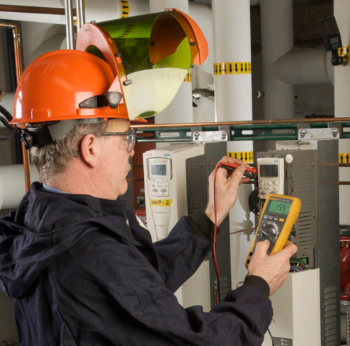
전기 감독인 Jim Murphy가 Fluke 179 DMM으로 40년이 넘는 노후한 증기 시스템에 새로 설치한 VFD에서 낮은 전압 신호를 살펴보고 있는 모습
