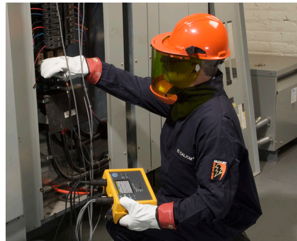
전기 기술자인 Rolf Zoeller가 Fluke 1735 3상 전력 로거로 병원 전기 시스템에 대한 부하 연구를 수행하는 모습. 이러한 시스템을 세밀하게 모니터링함으로써 에너지 스타 등급을 받을 수 있었습니다.
